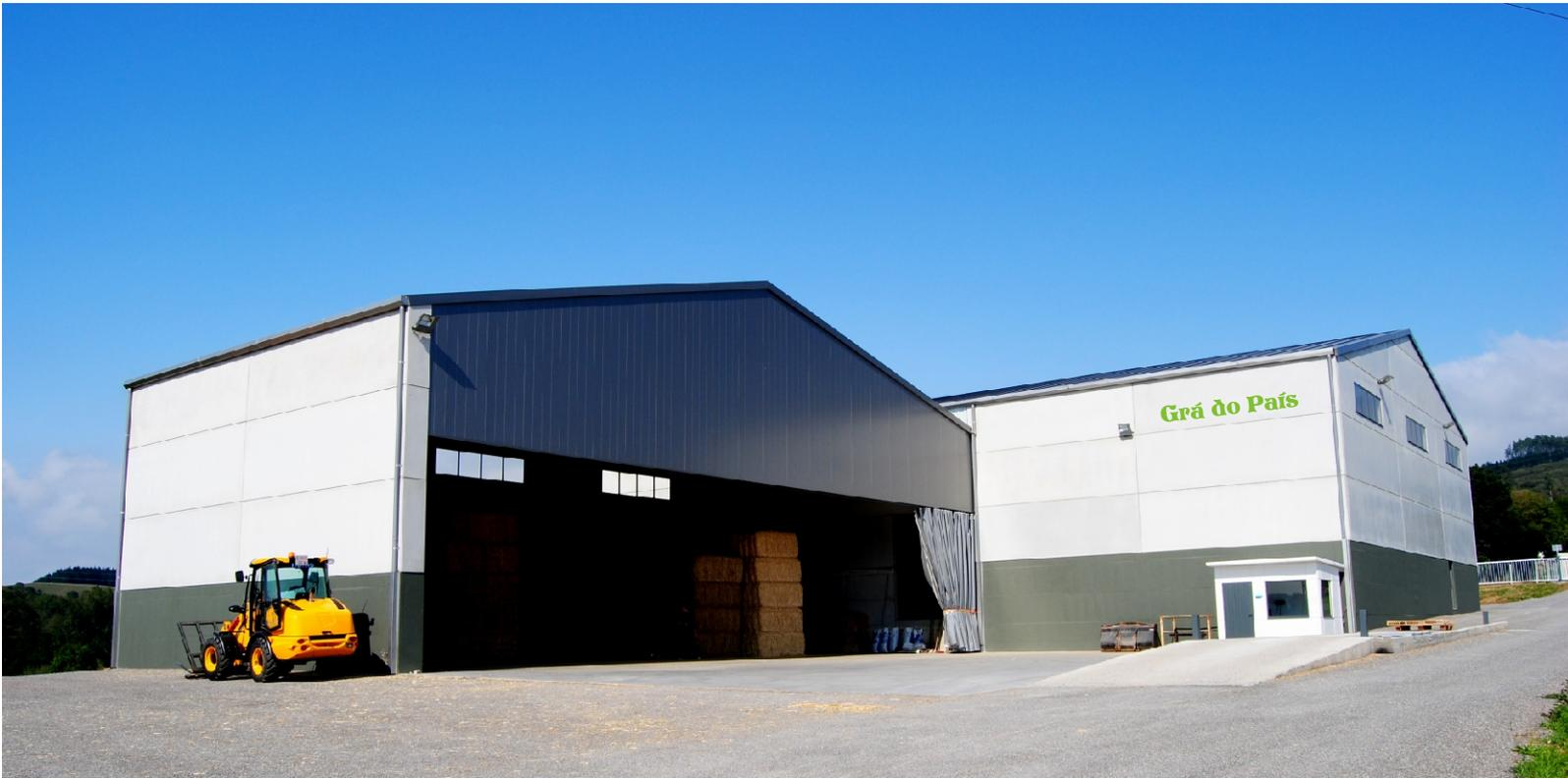
Construcción de dos naves adosadas a distinto nivel, en donde el cerramiento prefabricado se apoya en muros de hormigón de dos metros de alto, la instalación del cerramiento se ejecutó en 4 días laborables y cumplió todas las expectativas de la dirección de obra.
